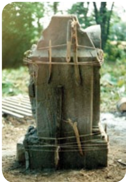
Smolnik n/Sanem, cmentarz greckokatolicki, piaskowcowy nagrobek NN, 2 poł. XIX w., VIII 1995 – powoli kończą się zachowane elementy, które można przykleić, widok cokołu z tyłu, widoczne nie dokończone gzymsy i groszkowane „plecy” cokołu.
