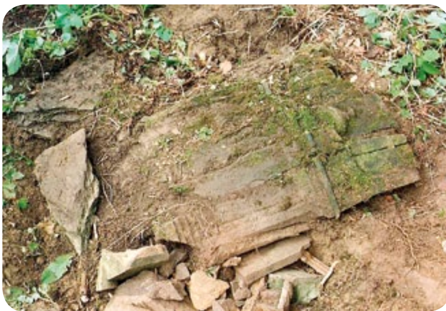
Smolnik n/Sanem, cmentarz greckokatolicki, piaskowcowy nagrobek NN, 2 poł. XIX w., VIII 1994 – stan zachowania, widoczne naturalne rozwarstwienie piaskowca, brak podstawy i krzyża wieńczącego cokół; odkopywanie cokołu.
