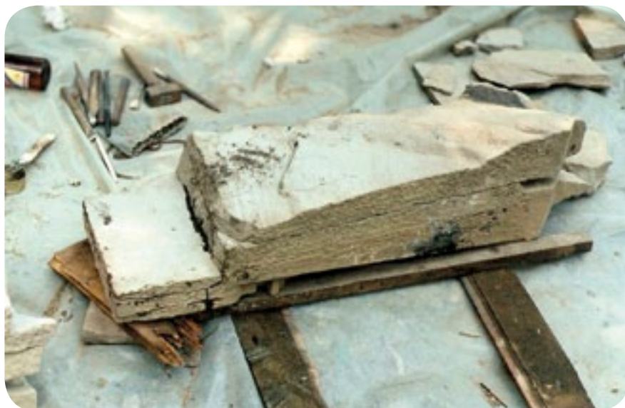
Smolnik n/Sanem, cmentarz greckokatolicki, piaskowcowy nagrobek NN, 2 poł. XIX w., VIII 1994 – początek klejenia zachowanych elementów cokołu, widok od tyłu.
