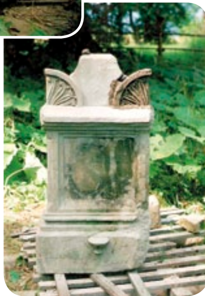
Smolnik n/Sanem, cmentarz greckokatolicki, piaskowcowy nagrobek NN, 2 poł. XIX w., VIII 1995 – początek prac rekonstrukcyjnych, widoczny zrekonstruowany akroterion.
