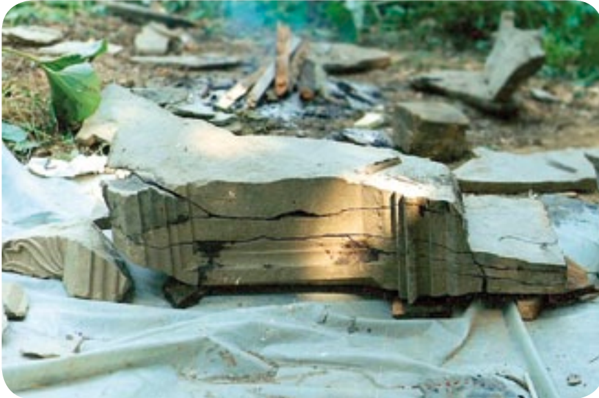
Smolnik n/Sanem, cmentarz greckokatolicki, piaskowcowy nagrobek NN, 2 poł. XIX w., VIII 1994 – początek klejenia zachowanych elementów cokołu, widok od przodu.
